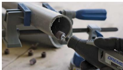
切断面のバリ取り作業
