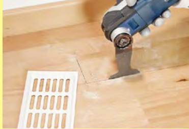
床材ポケット切断
