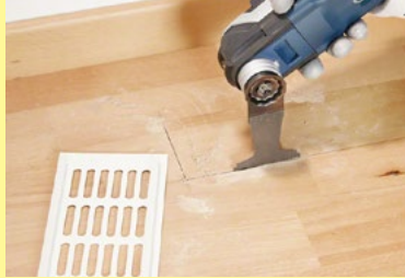
床材ポケット切断
