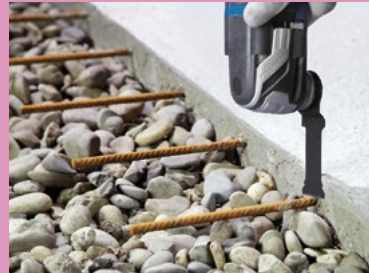
鉄筋面一切断
