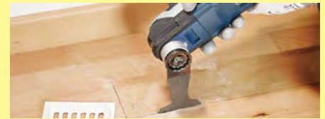
床材ポケット切断
