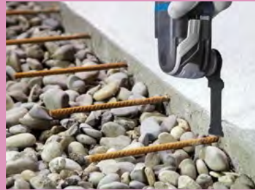
鉄筋面一切断
