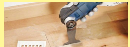
床材ポケット切断
