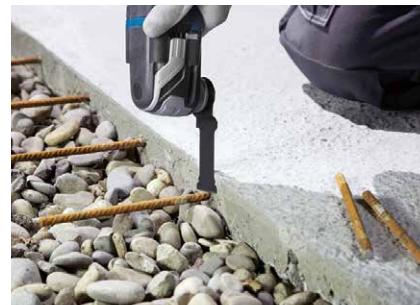
鉄筋の面一切断に
