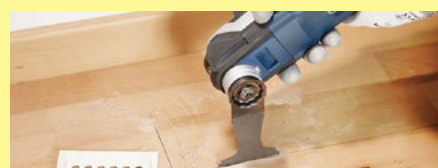
床材ポケット切断
