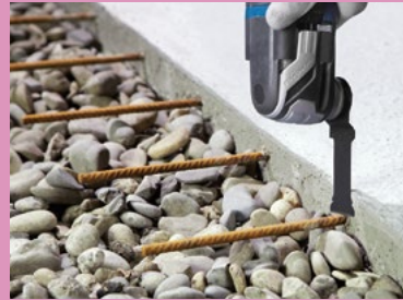
鉄筋面一切断
