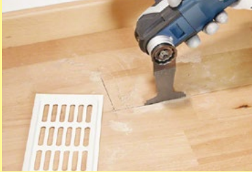
床材ポケット切断
