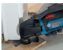
フローリングの突き合わせ部分に
